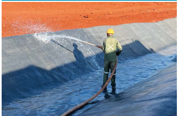
Монтаж CCSX™ для восстановления инфраструктуры крупных каналов
